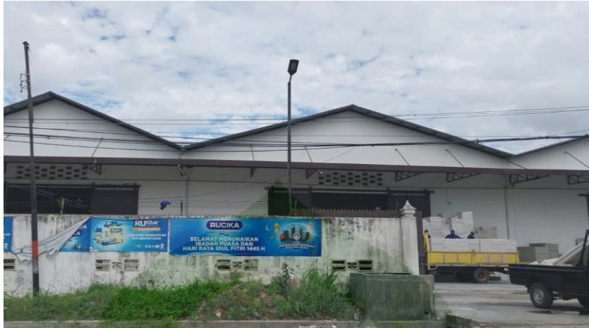
(Bangunan Gudang di Bili-bili, Kecamatan Suppa, Sudah sesuai dengan kawasan peruntukannya)
