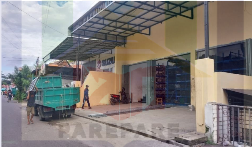
(Bangunan terindikasi melakukan aktivitas pergudangan yakni di jalan R.A. Kartini, Kecamatan Watang Sawitto)
