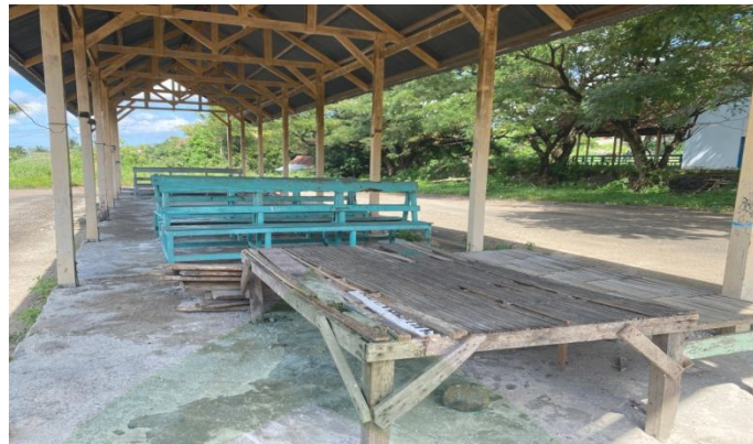
Gambar 4.1 Kondisi Sarana Prasarana atau Fasilitas Terminal Lapadde
