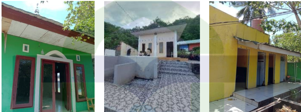
Gambar 4.4 Fasilitas Mushollah, Tempat Wudhu, dan Toilet
