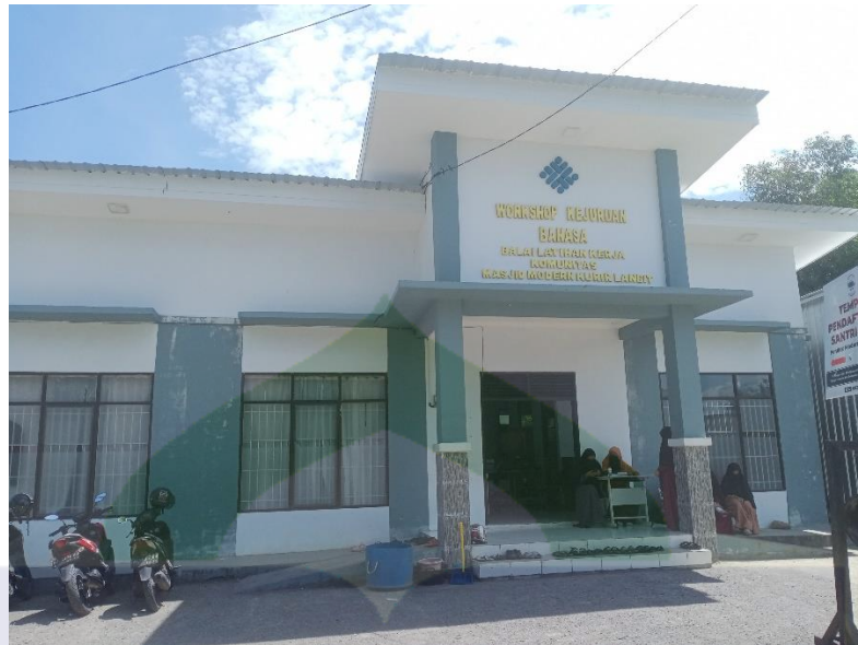
Gedung Workshop Kejuruan Bahasa dan Balai Latihan Kerja
