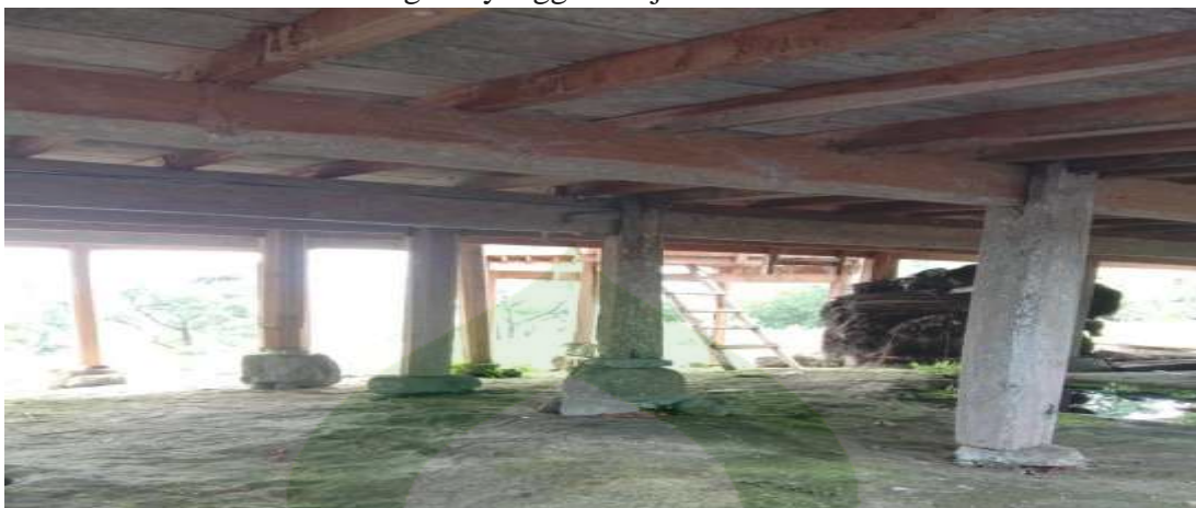
Tiang Penyangga Masjid Tua Tondon
