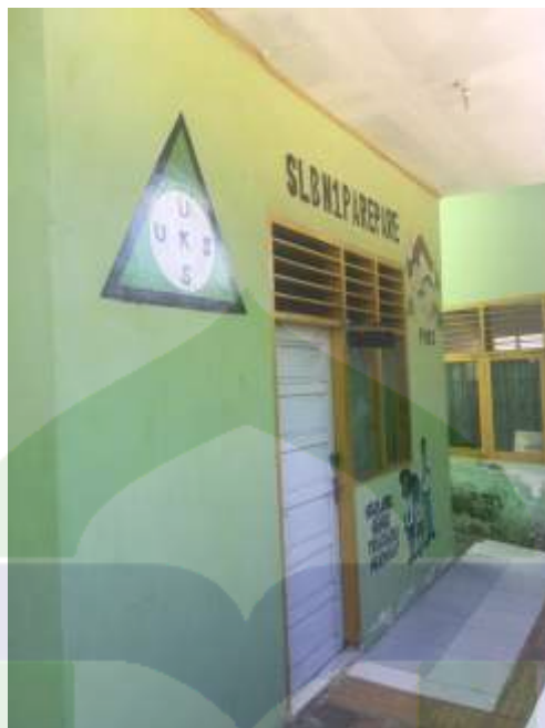
Gambar 9. Ruang UKS SLB Negeri 1 Parepare
