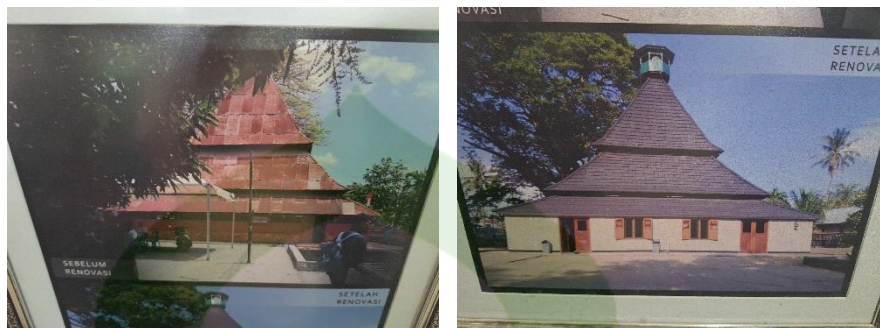
Gambar 1. 3 Gambar Masjid Tua Jerra'e Sebelum & Sesudah di Renovasi
