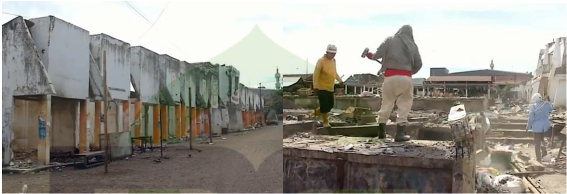
4. 1 Kondisi Pasar Sumpang Minangae Saat Perbaikan Infrastruktur di Tahun 2017
