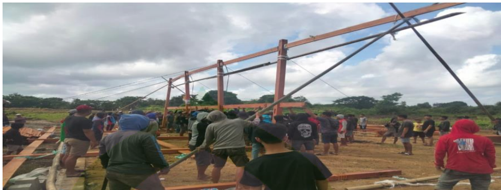
Gambar 4.9 Proses Mappatettong Bola (Mendirikan rumah)
