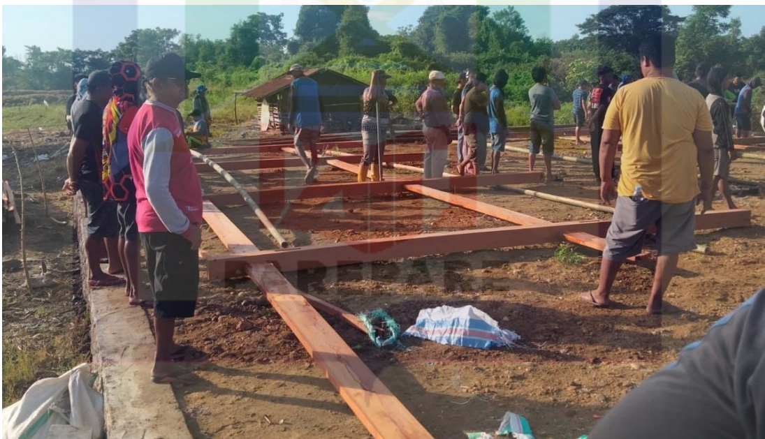
Proses Mattolo Bola (Perangkaiaan rumah) di Kelurahan Amparita
