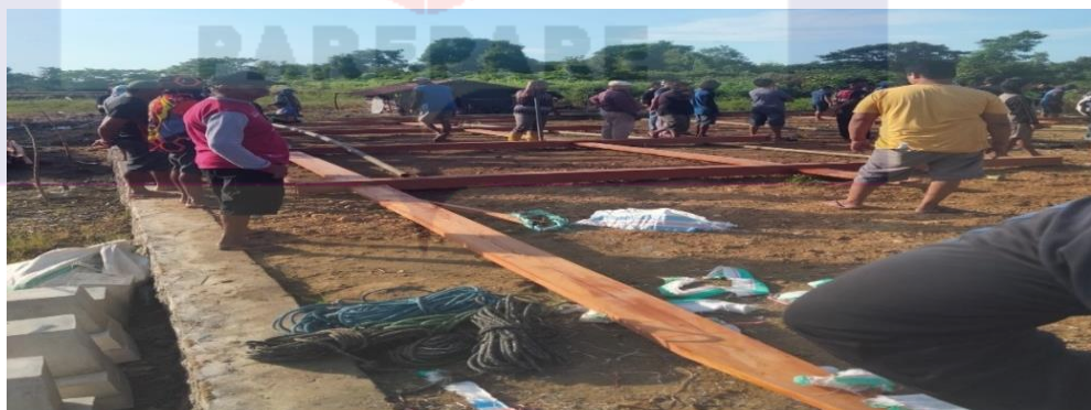
Gambar 4.5 Proses Mattolo Bola (perangkaiaan rumah)
