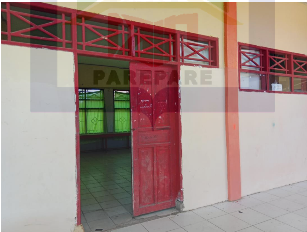
Tampak Depan Ruang Laboratorium PAI
