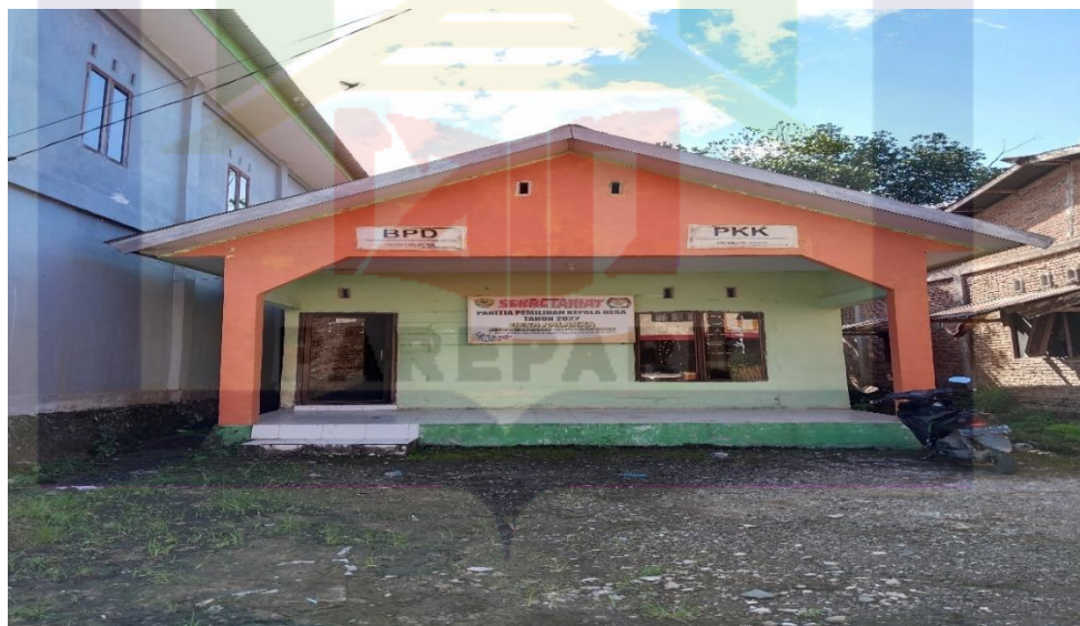
Gedung Sekretariat Desa Palakka
