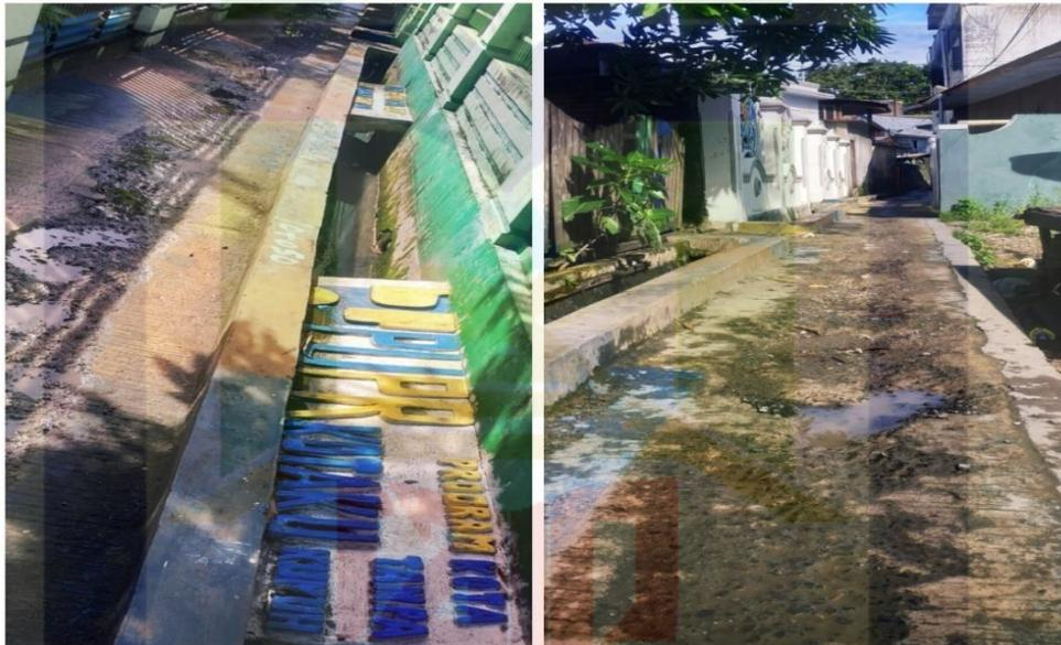
**Gambar 2.4 Drainase yang telah dilepas akibat air yang meluap dan kondisi jalan yang telah dibangun.**
