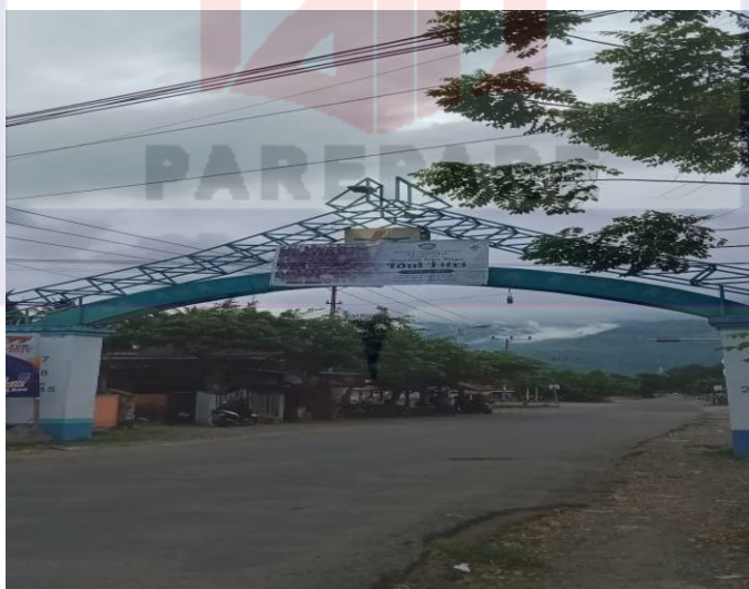
Gambar 4.1 gerbang PLTU Bakaru menuju kawasan air terjun karawa
