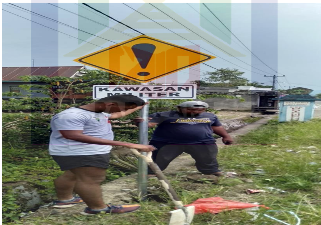
Gambar 6: pemasangan rambu di Kec. Patampanua
