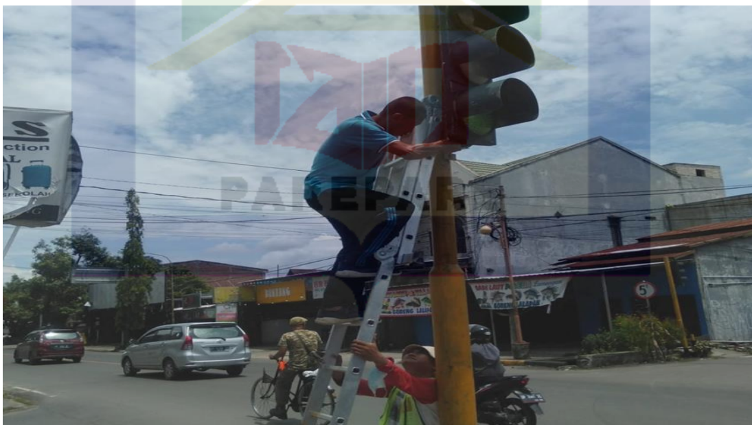
Gambar 4: pemasangan Traffic light di Jl. Jend. Ahmad yani. Poros Pinrang guna memantau Arus lalu lintas
