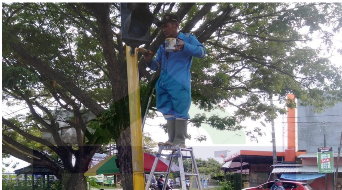
Gambar 5: pengecekan dan Perbaikan Rambu Tranffic Light di JL. Langnga
