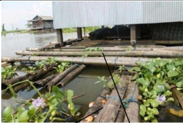
Gambar 6: Rakit pada Rumah Terapung Sumber: Naing & Halim, 2013
