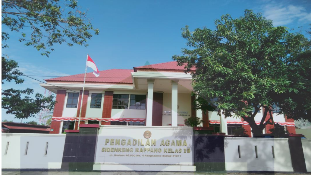
Pengadilan Agama Sidenreng Rappang Tampak Depan
