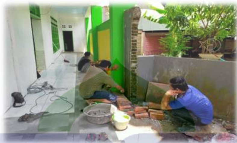
Proses Renovasi Masjid Dusun Kanni Kecamatan Paleteang Kabupaten Pinrang
