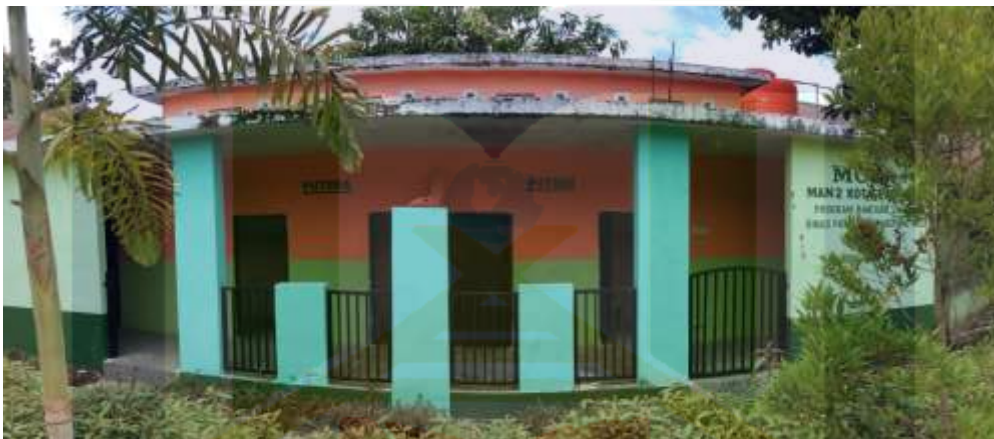
WC/ Toilet MAN 2 Parepare
