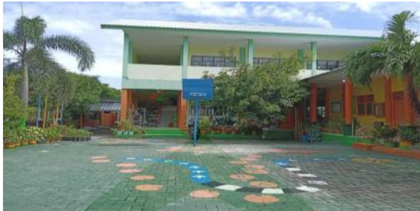
Gambar 4.3 Gedung SD Negeri 28 Parepare
